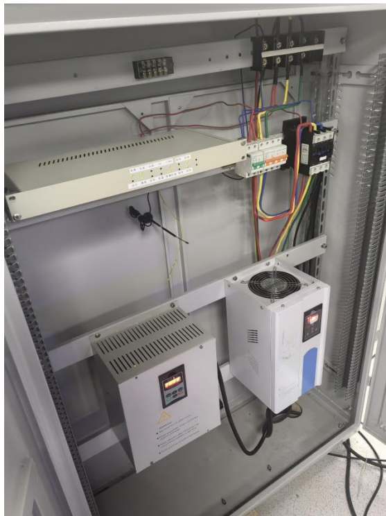
图 5.2 电磁加热模块串联方式示例
